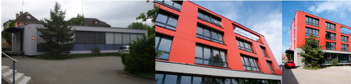
Abbildung: Aufstockung Hofackerstr. Häring Holz- und Systembau AG
