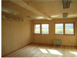
Abbildung 5: Brettsperrholzcontainer Innenansicht
