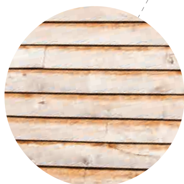
Fassade Typ 1 Stülpschalung horiz. Sägerau, unbehandelt
