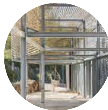
Struktur Laubengang Metall Profile, feuerverzinkt
