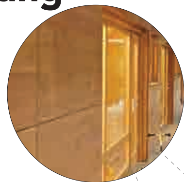
Fassade Typ 2 Laubengang Sperrholzplatten farblos lasiert, gestrichen
